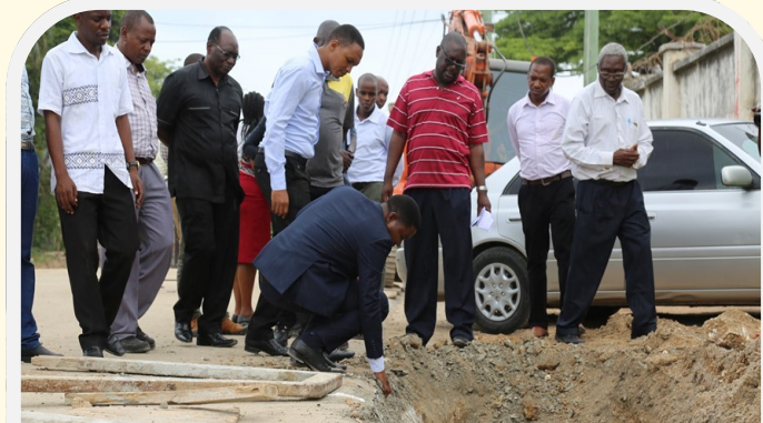
Waziri wa Nchi OR-TAMISEMI Mhe. Selemani Jafo (aliyeinama) akikagua ujenzi wa miundombinu katika barabara ya Makumbusho inayojengwa kupitia mradi wa DMDP
